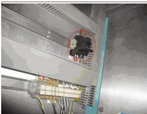
照片(一)導致銀幕無法顯示的接點。
