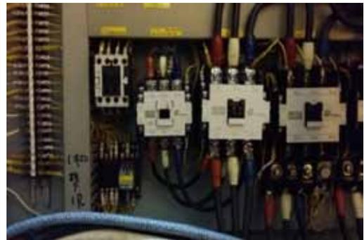
照片(四) 電磁接觸器及電磁開關
