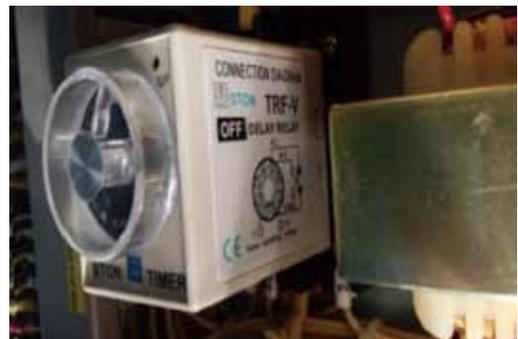
照片(八) 斷電延遲式電驛
