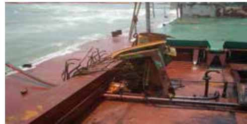
照片二：颱風過後 永昌輪絕大部分舷牆以及通風筒 皆已滅失
