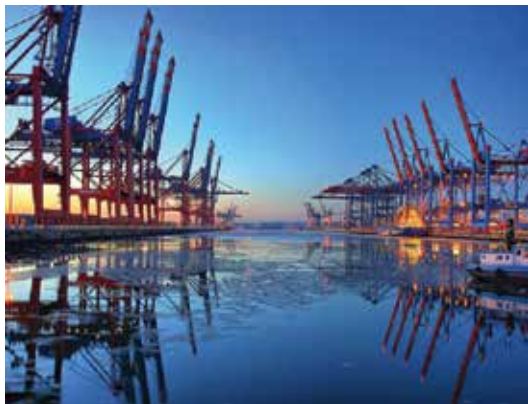
排列於漢堡港貨櫃碼頭作業區的貨櫃起重機
