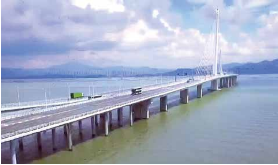
深圳-香港大橋(又稱「深圳灣大橋」)
