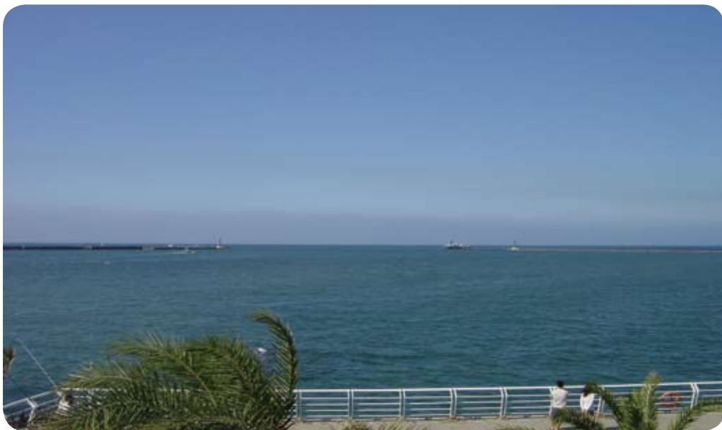
▲高雄第一港口和兩道防波堤，堤端各有一座燈桿
