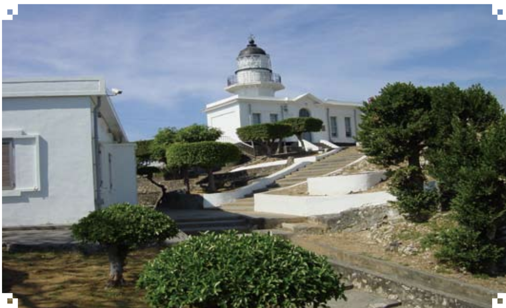
▲ 高雄燈塔(旗後燈塔)
