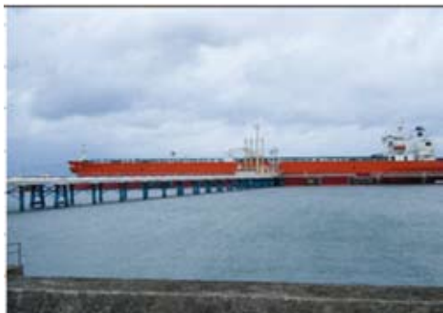
圖35鹿兒島喜入ENEOS石油轉運站油輪作業狀況
