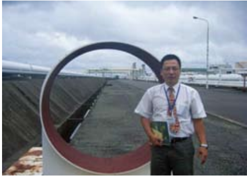
圖36鹿兒島喜入ENEOS石油轉運站最大油管直徑1410mm
