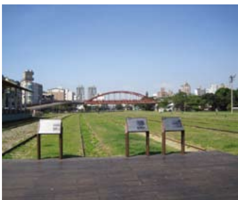
▲「高雄港火車站」的舊鐵道和說明牌示，前方之橋梁為跨鐵道而建，連通臨海路和公園路的L型路橋
